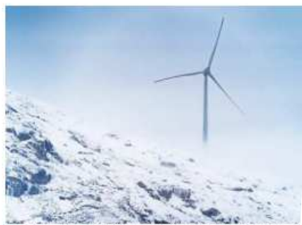
Eines der vierzig bestehenden Schweizer Windräder steht auf dem Gotthardpaass.
